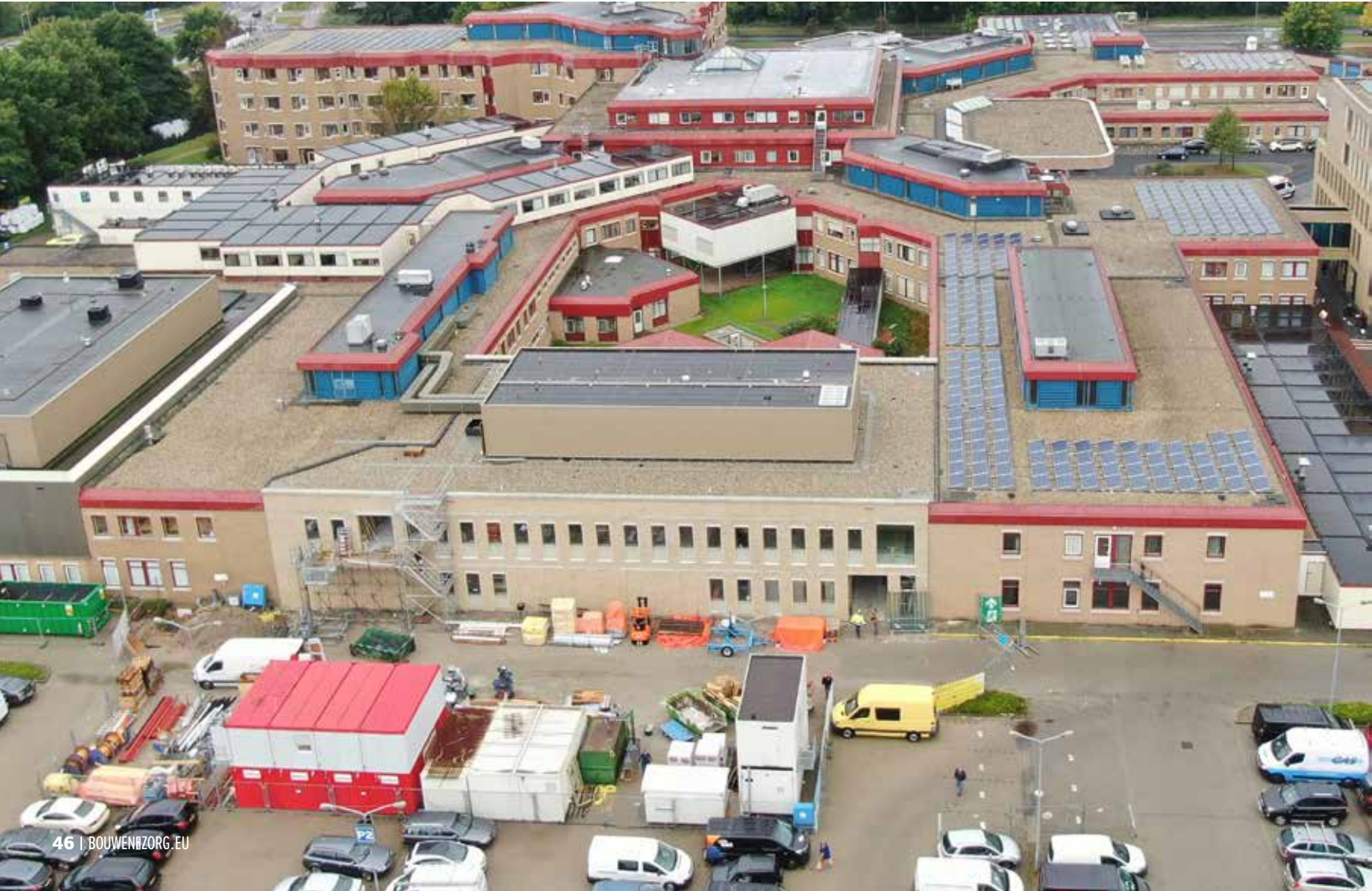
Het nieuwe bouwblok bevindt zich tussen twee bestaande vleugels, met op het dak duidelijk zichtbaar het techniekgebouw.
