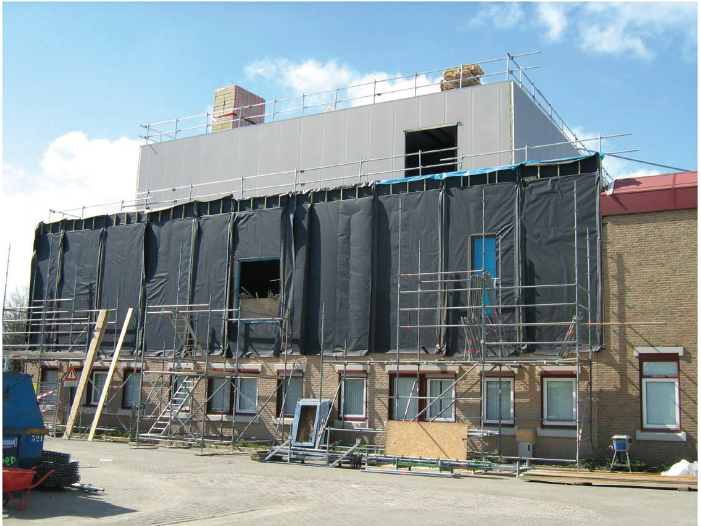
De nieuwe OK's in aanbouw, boven op de huidige SEH. Op het dak verrijst de nieuwe technische ruimte.
